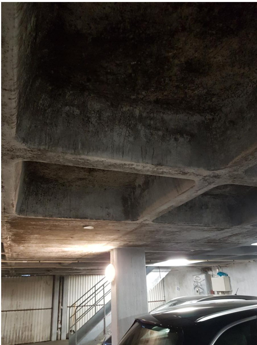
BILD 8. Mögelpåväxt i garage L.
