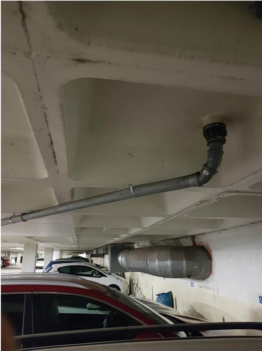
BILD 6. Läckage, samt genomgående skjuvspricka i vägg- garage N.
