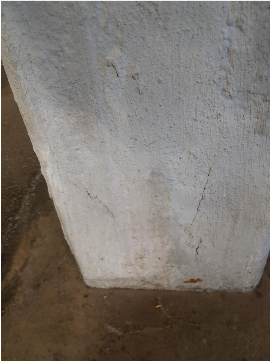
BILD 3. Spjälkningskada pga kloridkontaminerad betong. Armeringen rostar.
