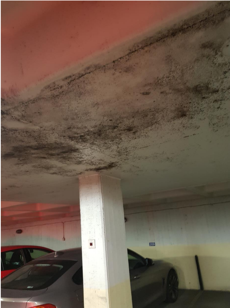
BILD 7. Mögelpåväxt i garage N.
