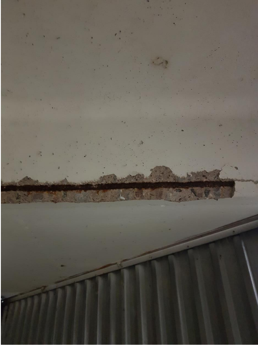
BILD 4. Spjälkningsskada i takkassett garage N.
