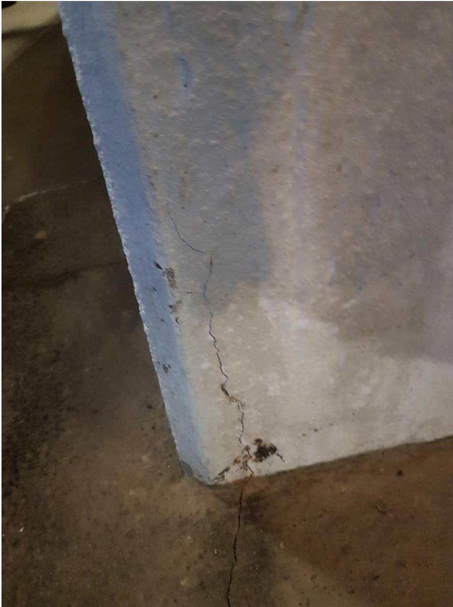
BILD 1. Pelare med betongskador till följd av rostande armering.
