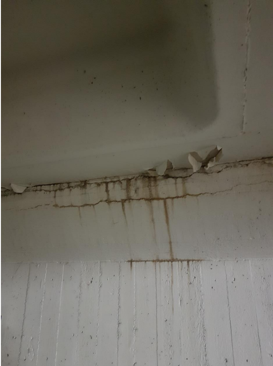
BILD 5. Läckage /spjälkningskada i takvinkel garage N.
