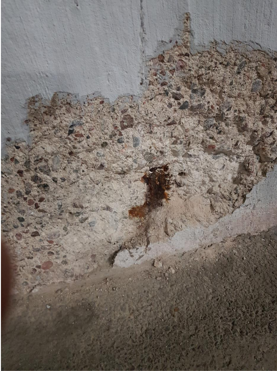
BILD 2. Spjälkningsskada i golvvinkel garage N.
