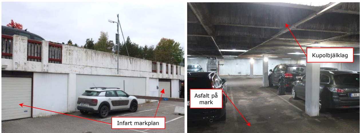
Bild 1-2. Översikt av ut- och insida av garaget.
