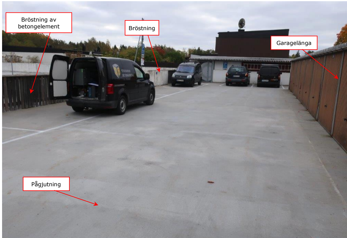
Bild 8. Utomhus del av garage, ovsida bjälklag.
