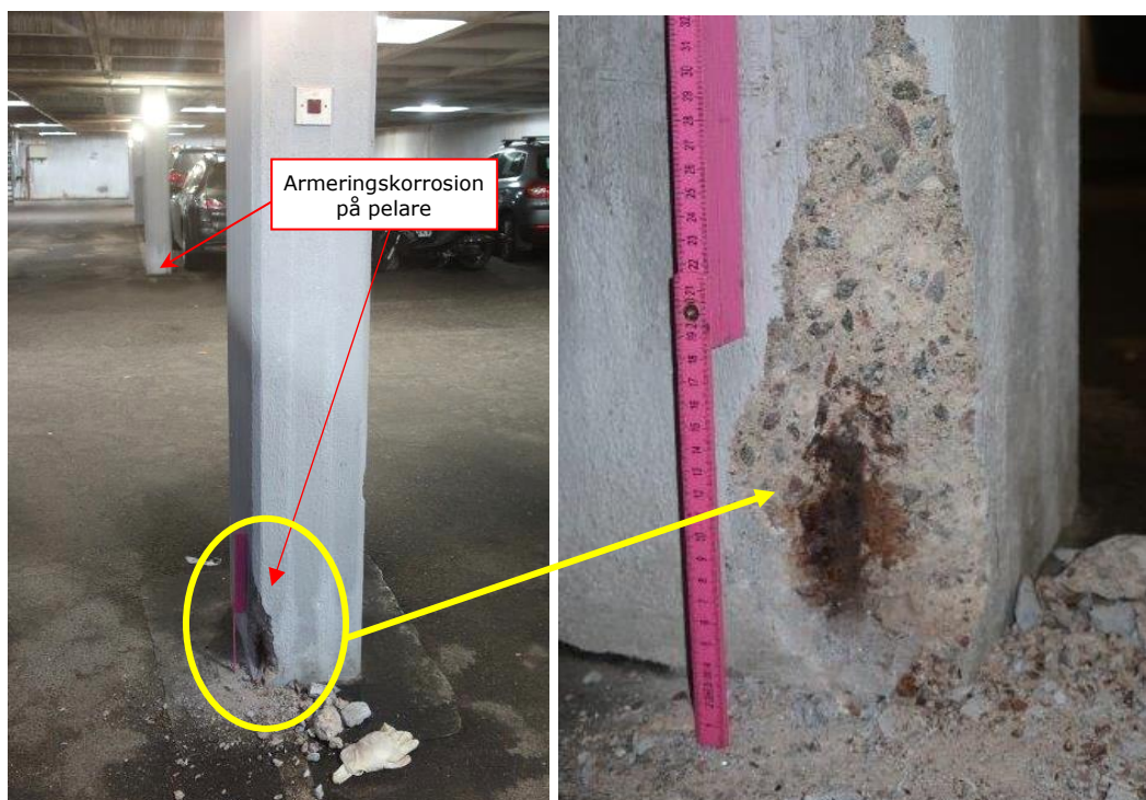
Bild 3-4. Pelare med spjälkskada pga. armeringskorrosion.
