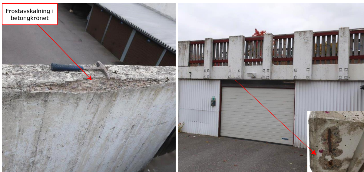
Bild 9–10. Skador på bröstningar och betongelement.
